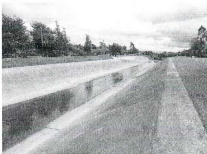
Fotografía 20. Canal Torca. Fuente: Autor, Fecha: 26 de julio de 2016.
